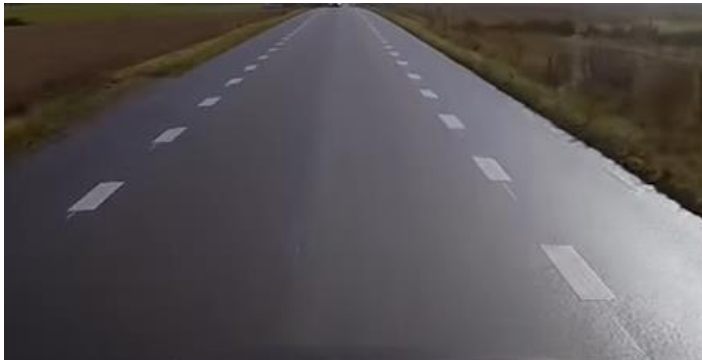
Figur 3. Bild på Bygdeväg, med ett körfält för bilar och två bredare vägrenar på var sida om detta körfält.
